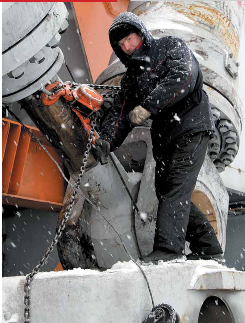
На монтажной площадке разреза «Красногорский» завершается сборка экскаватора ЭШ-20/90 производства ОАО «Уралмашзавод»
